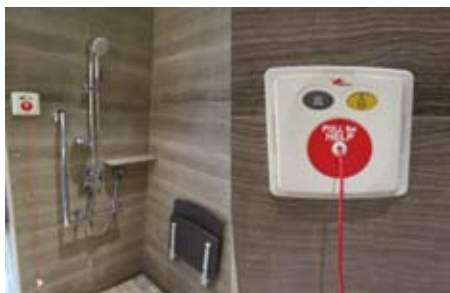
在坐便器和淋浴旁，都有一个。上面写着“HELP”，是紧急呼叫装置。这种设计很人性化，在紧急的情况下，拉绳要比按钮更省力，而且拉绳可以覆盖的面积更大。这么贴心，感觉住在这里好踏实。
